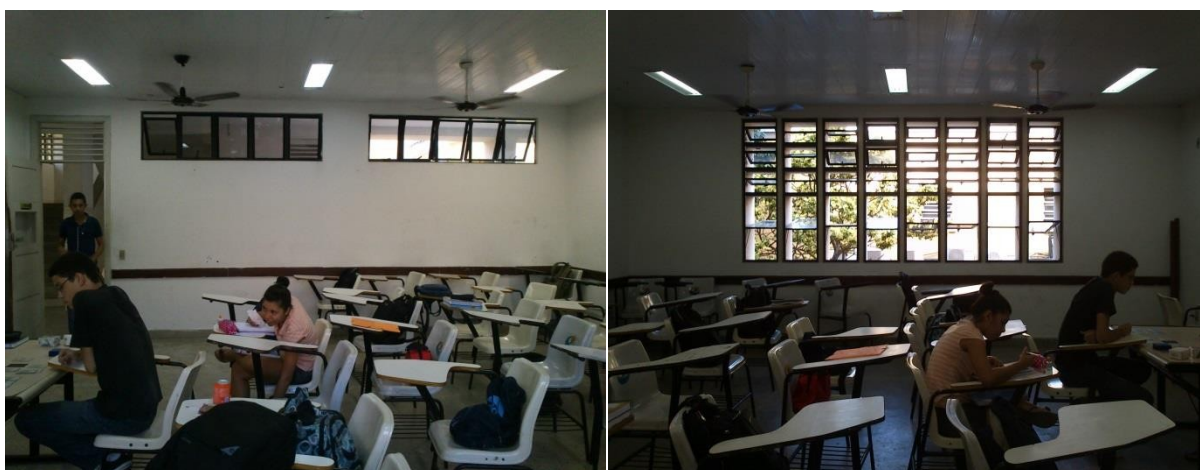
Figura 41 – Fotografia das aberturas para ventilação na sala do Bloco Central.
