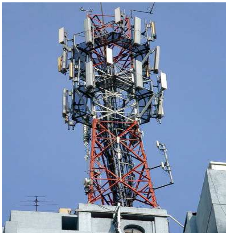
Figura 24 - Torre de ERB no topo de edifício. Fonte: Autor
