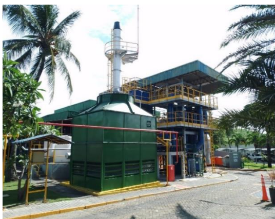
Figura 2 - Vista geral do incinerador de Fortaleza-CE
