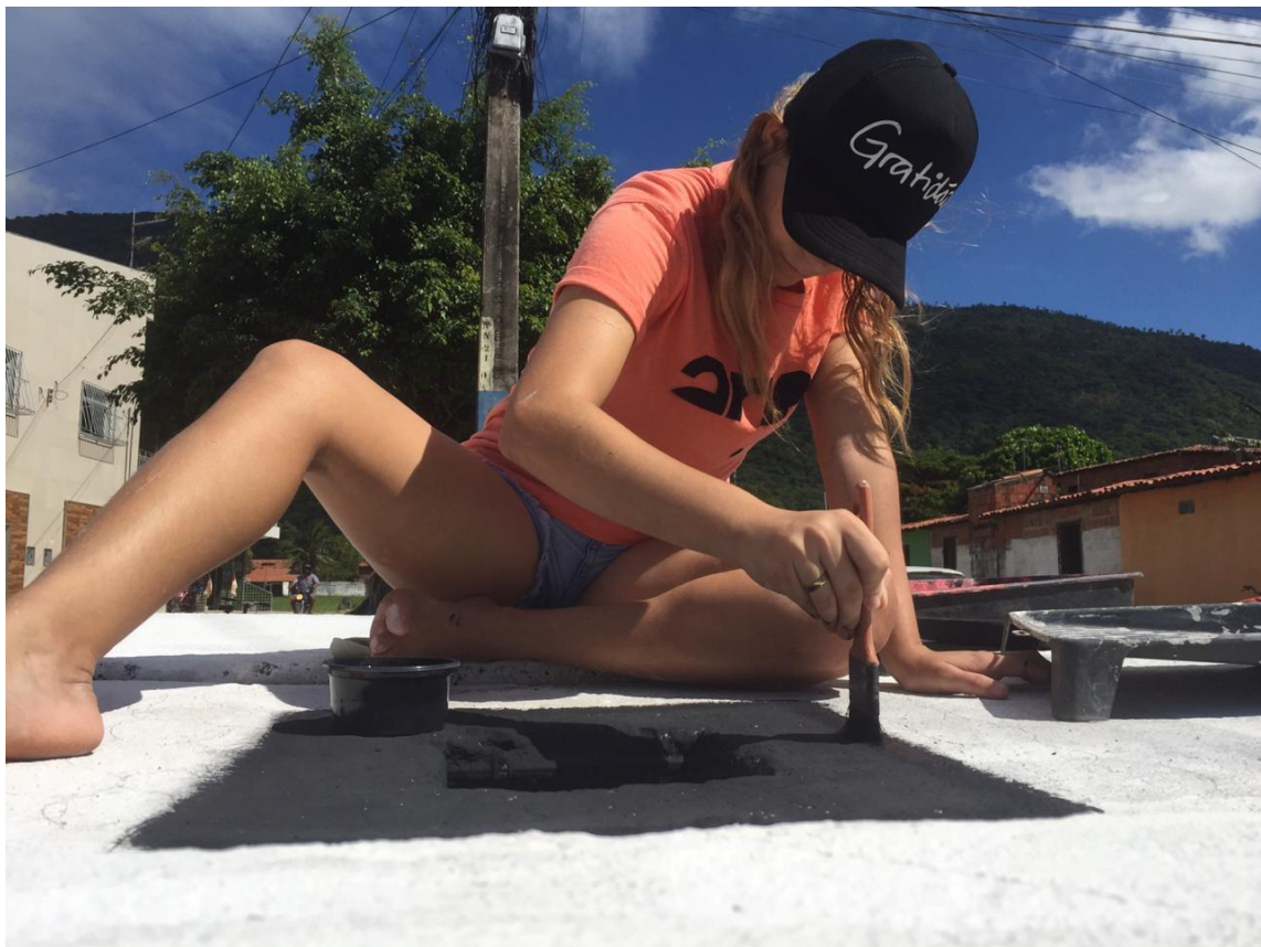
Figura 26 — Gleyce, pintando em volta da abertura do tanque.
