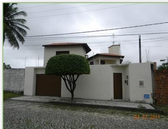
Figura 35 - Casa 01 - Fachada principal externa (oeste). Fonte: Adeildo Cabral da Silva, 2011.
