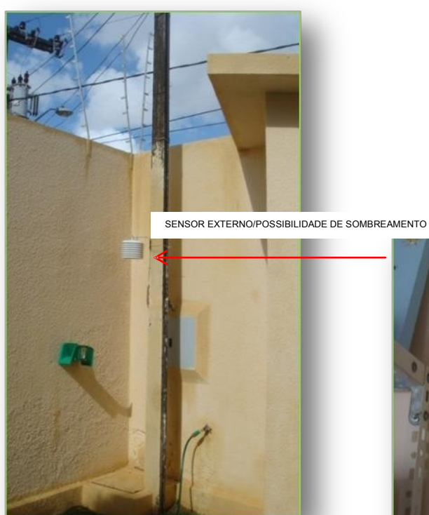
Figura 36 - Casa 01 - Sensor (HOBO) externo – oeste
