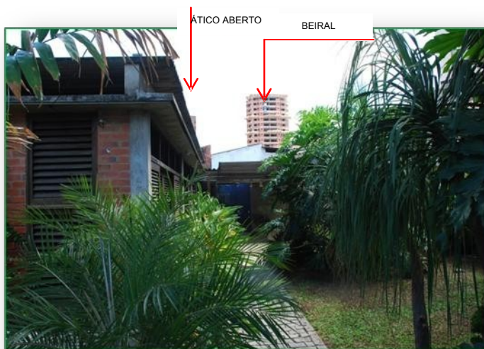
Figura 44 - Fachada interna. Fonte: Arquivo Pessoal, 2001.
