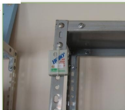
Figura 37 - Casa 01 - Sensor interno (HOBO) gabinete – pavimento superior
