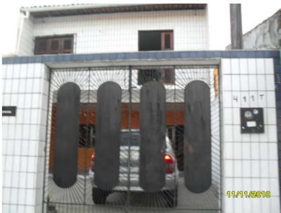
Figura 64 - Casa 04 – Fachada Principal. Fonte: Sarah Oliveira, 2010.
