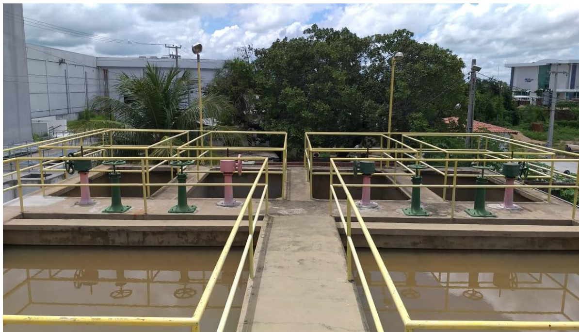
(f) decantadores e filtros rápidos descendentes
