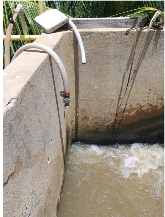
(c) aplicação do polímero catiônico antes da entrada no floculador.
