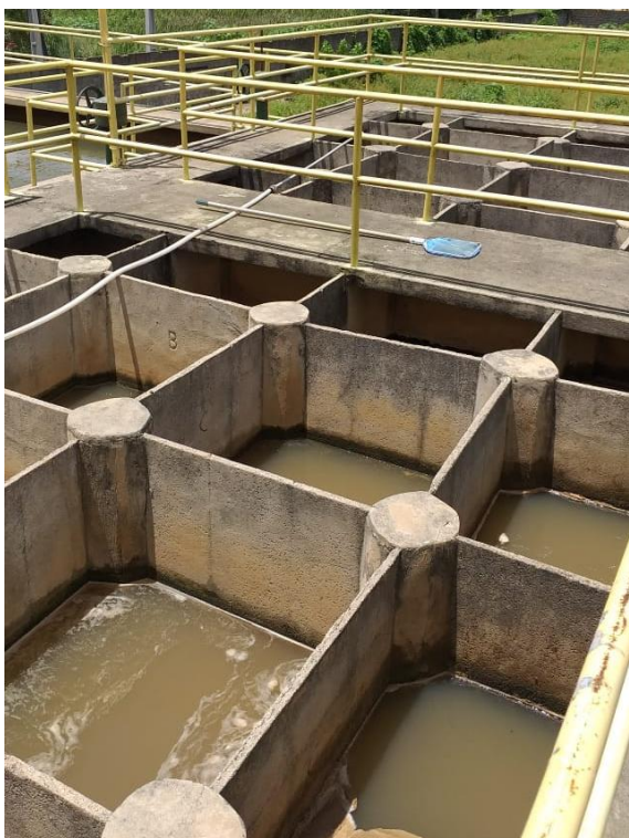
(d) canal de floculação com chinacas verticais
