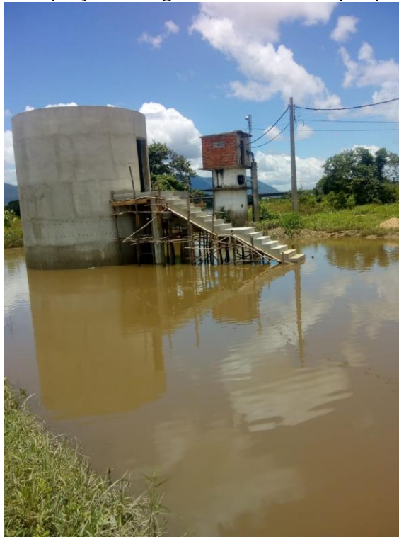
Figura 4 – Captação das águas do rio Acaraú por poço amazonas.
