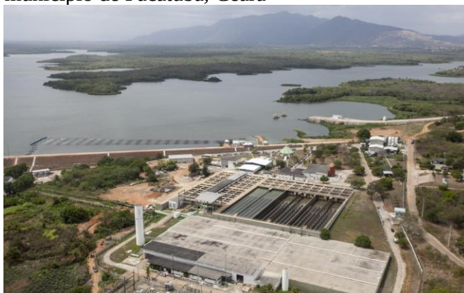
Figura 7 — Vista aérea da ETA em estudo no município de Pacatuba, Ceará
